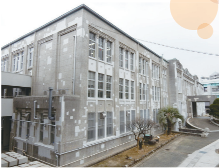
耐震工事が終了した校舎。 修理した箇所が白く、モザイク模様になっていますが、 数年経てば、周囲になじんで同じ色になるそうです。
