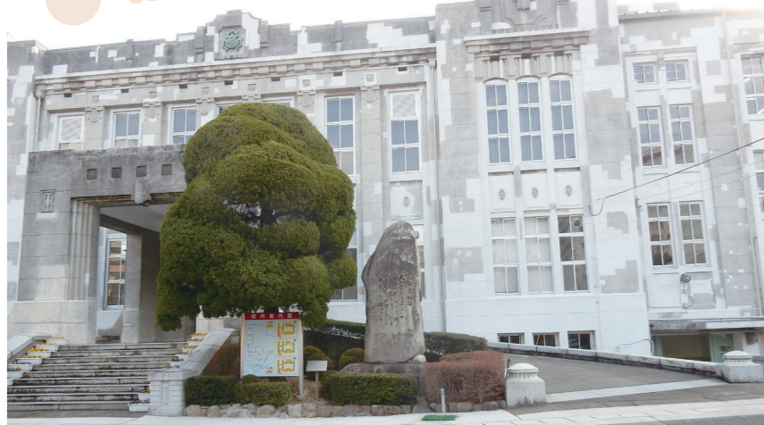
耐震工事が終了した校舎。 修理した箇所が白く、モザイク模様になっていますが、 数年経てば、周囲になじんで同じ色になるそうです。
